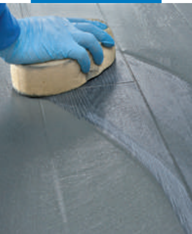
Окончательная очистка плитки с помощью целлюлозной губки
