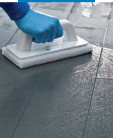
Очистка швов падом Scotch-Brite® (когда материал начал схватываться)
